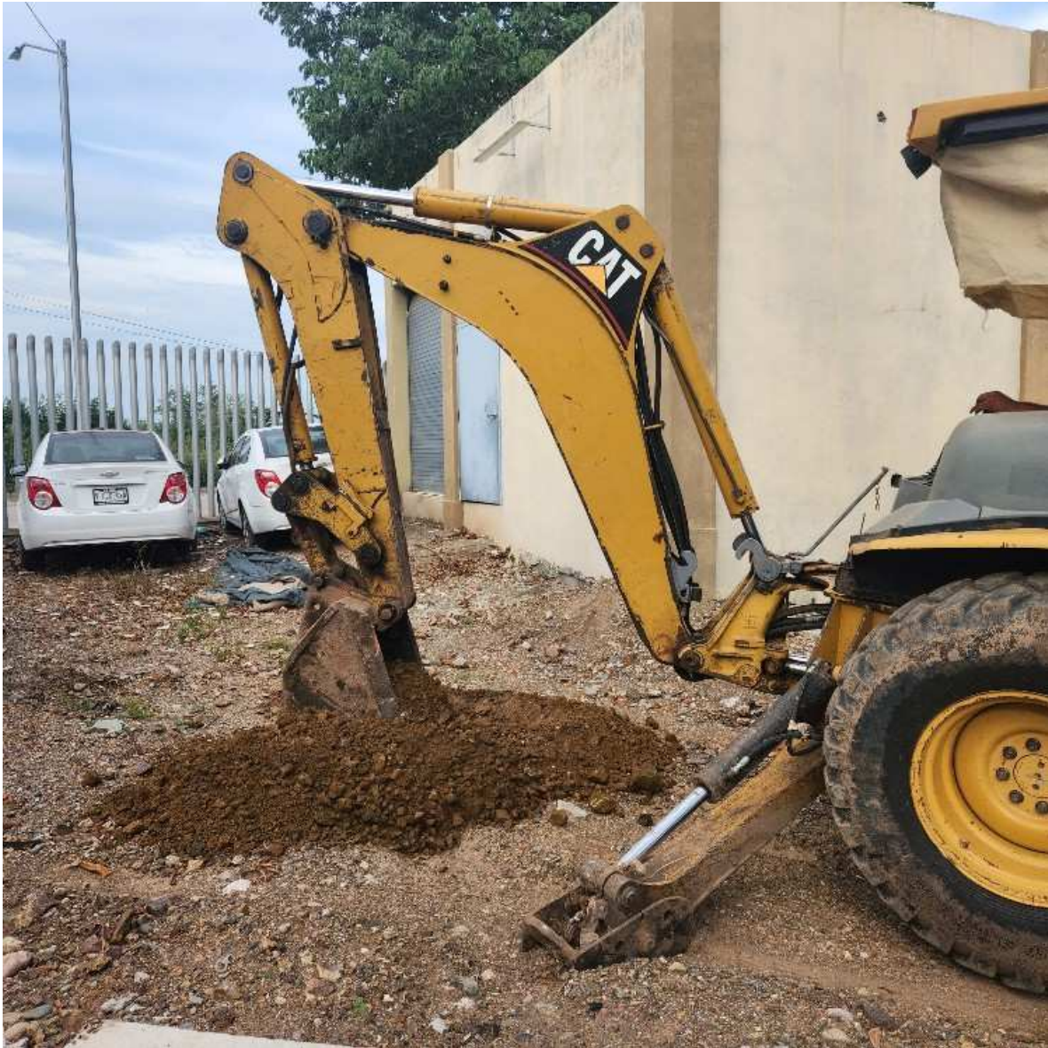
Pozos a cielo abierto realizados (PCA-2).
