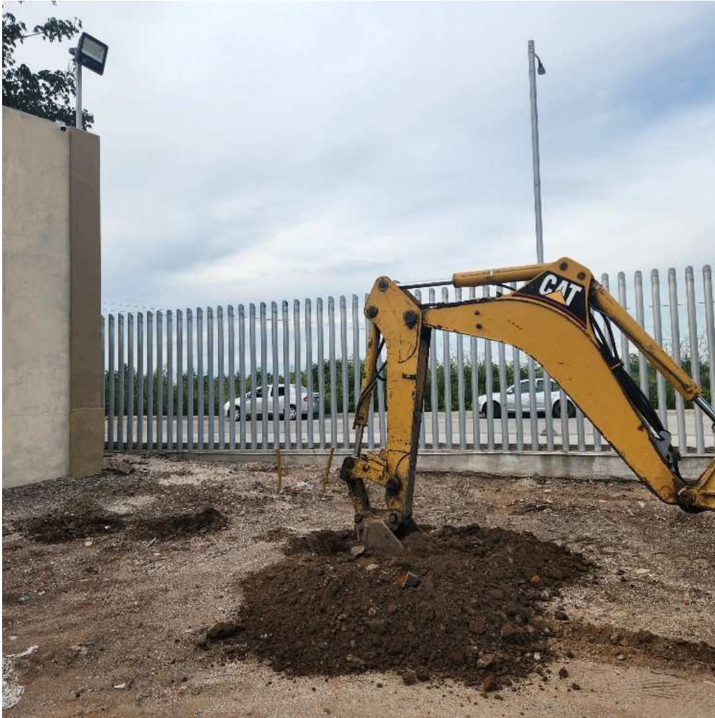
Pozos a cielo abierto realizados (PCA-1).
